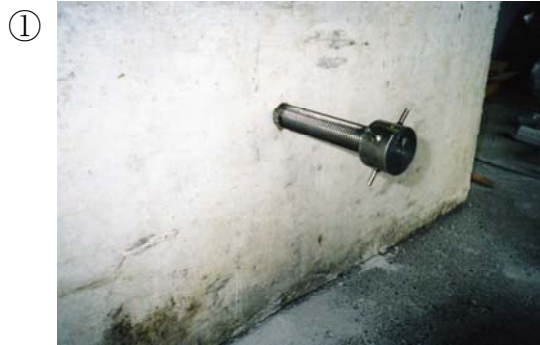
横壁にアンカ部を打ち込む。
