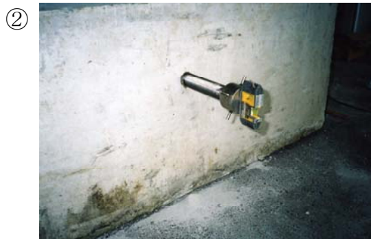
ゲート弁体に対して水平になるよう調整する。
