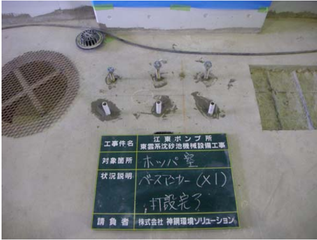
<アンカー打設>
