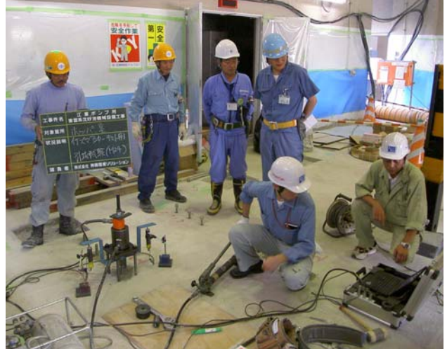
<アンカー引抜試験>
