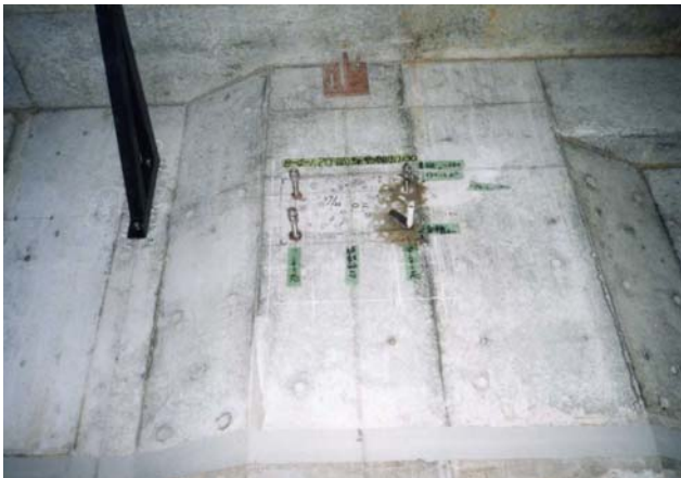
<アンカー打設>
