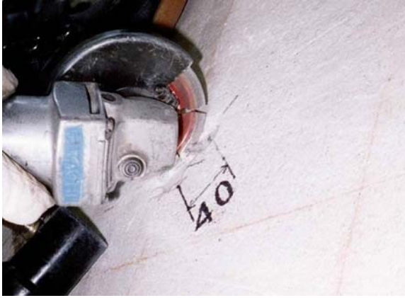
<コンクリート表面をカッター切り>
