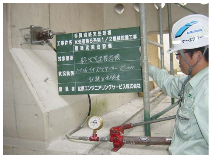
<引抜荷重 25KN 異常なし>
