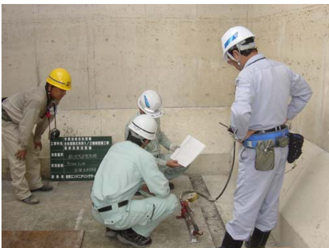
<M16 新型イナズマアンカー役所立会試験>
