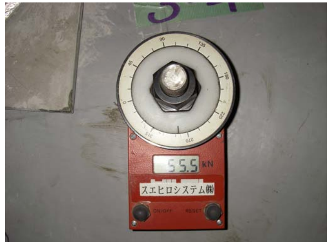
<アンカー引抜試験>
