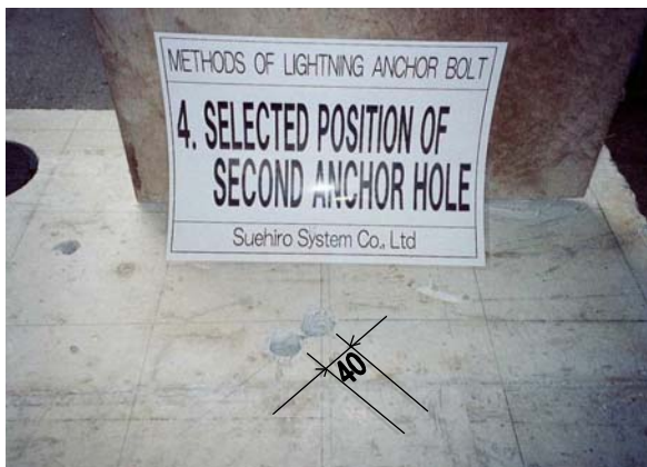
<第2 アンカーボルト孔の穿孔>
