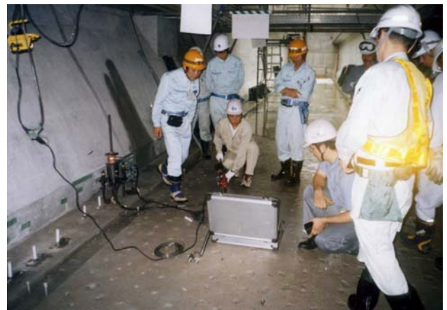
<アンカー引抜試験>
