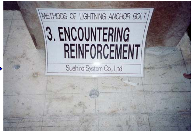
<穿孔位置に鉄筋干渉>
