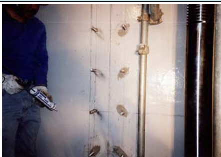
<アンカー打設>
