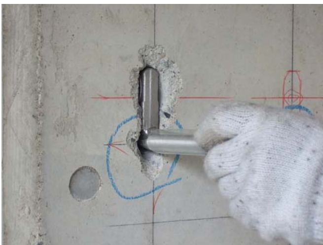
<M16 新型イナズマアンカー仮挿入>
