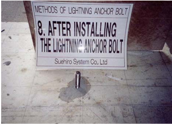
<イナズマアンカーボルト取付完了>
