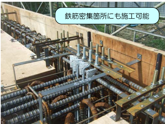
<梁中にアンカーボルト取付 側面図>
